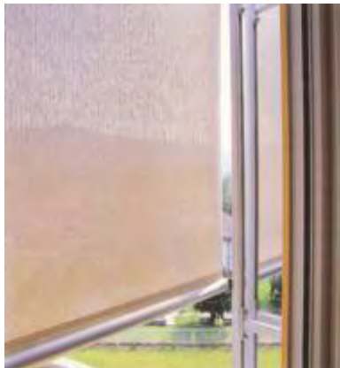
Bei der fassadendistanzierten Ausführung kann das Soltis Screen-Gewebe die Wärme zwischen Behang und Fensterscheibe optimal ableiten.
